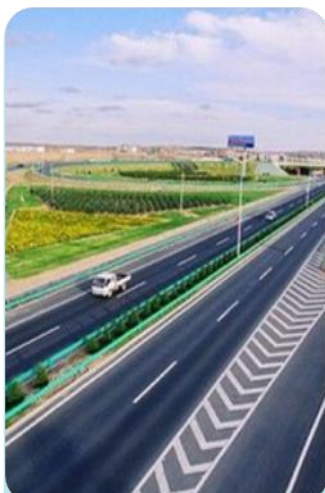
基础设施建设
